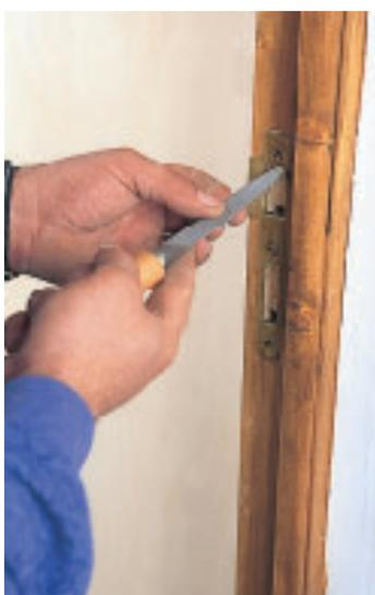
10. Choisir une lime dont la forme est proche de celle de la pièce à ajuster. Ici, une lime demi-ronde pour ajuster la forme circulaire de la pièce.
